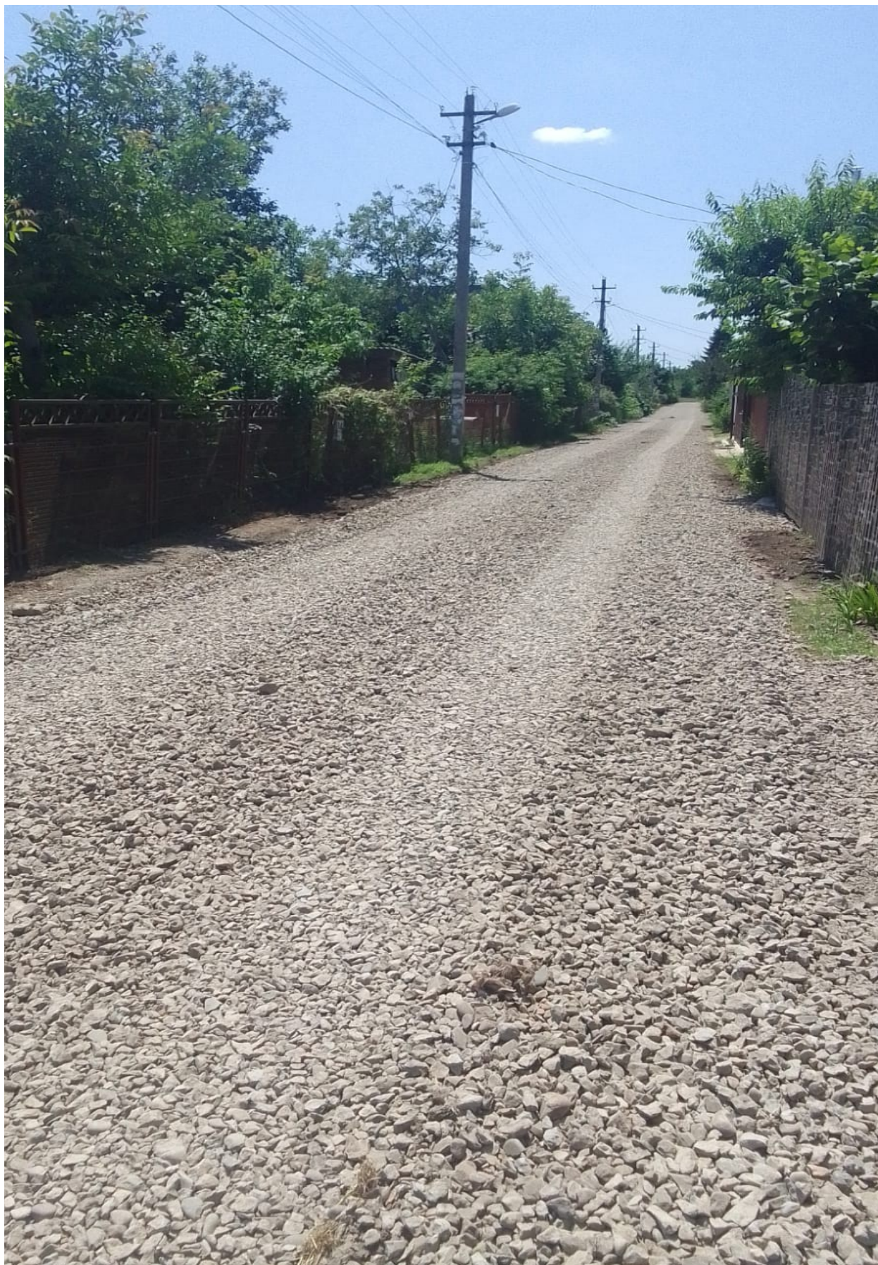
Фото. РЕМОНТ ДОРОГ УЛИЦА СОЛНЕЧНАЯ.
