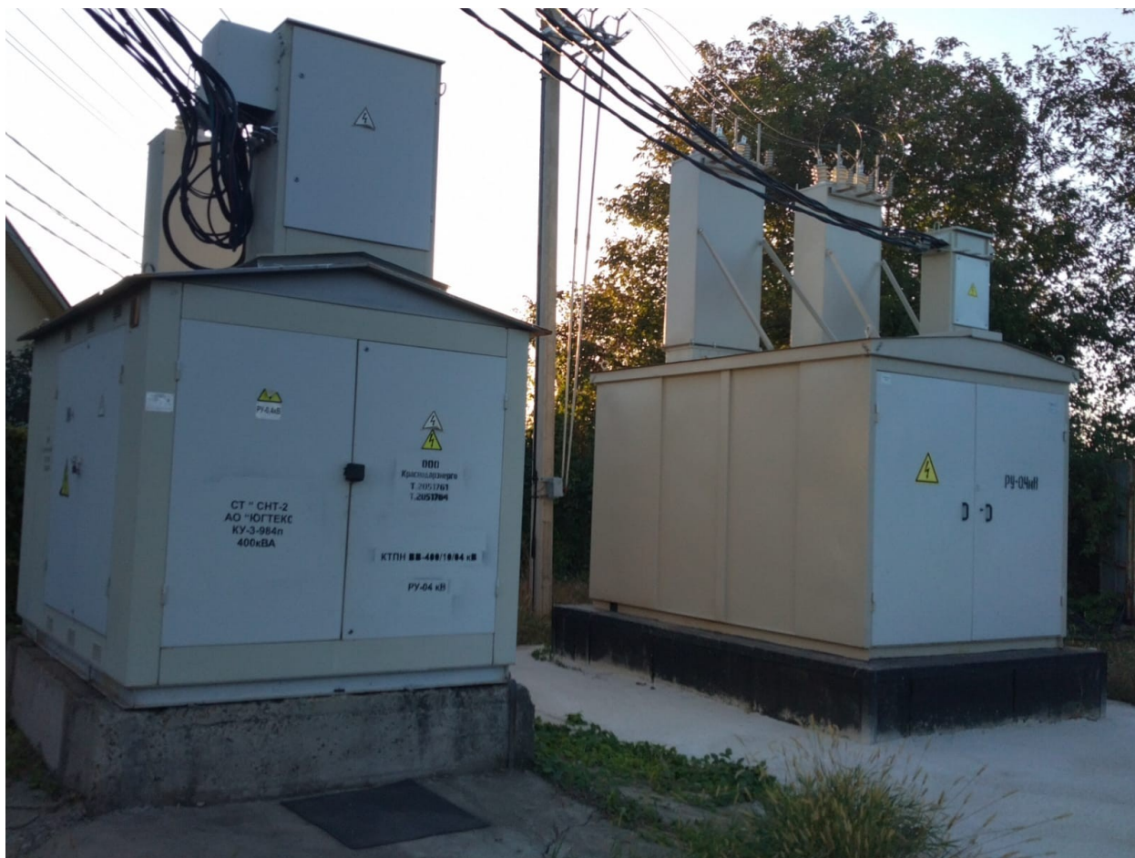
Фото. ПОДСТАНЦИЯ СНТ № 2 АО «ЮГТЕКС»
